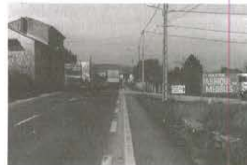
Le trottoir de la RN 110
