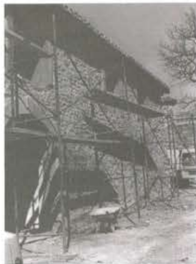
Travaux pour les gîtes ruraux
