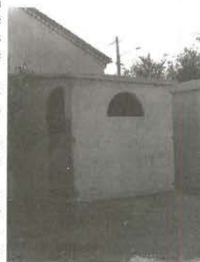
Toilettes de la Maison pour Tous
