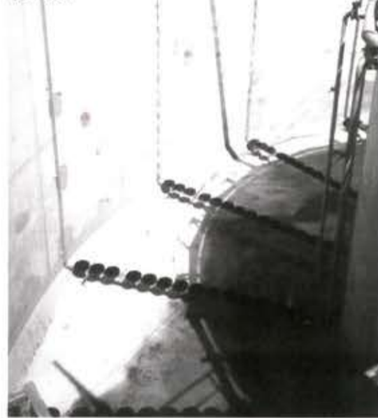
Le bac principal de la nouvelle station d'épuration, avec les insuffleurs à bulles, visitée par 300 personnes lors de la journée portes ouvertes du 26 mars
