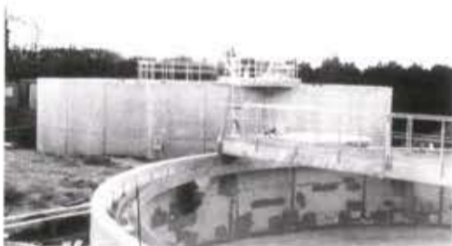
Etat actuel des travaux à la station d'épuration Photo M.C. Midi-Libre
