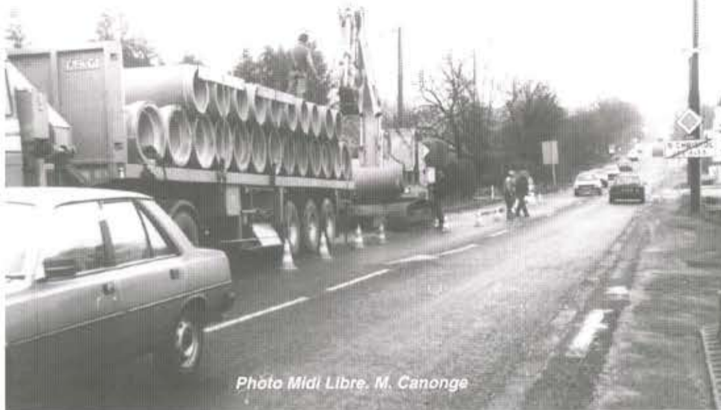
Début travaux RN 110. Entrée ST CHRISTOL
