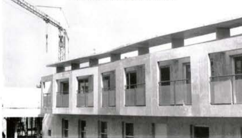
Le chantier de la Maison de Retraite
