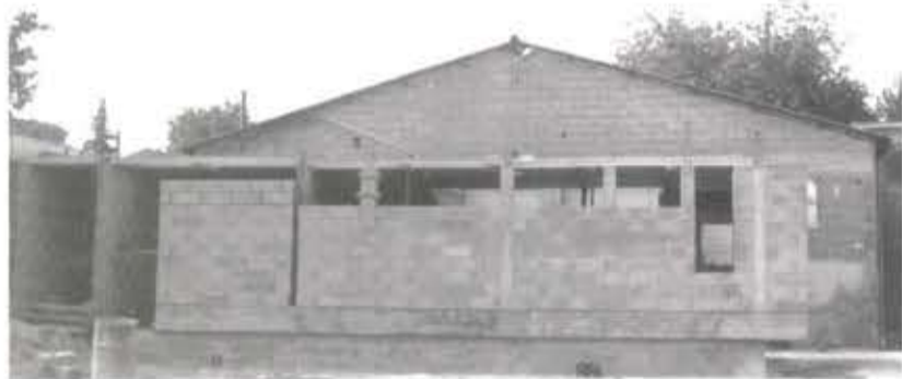
Le chantier de la Salle des Sports
