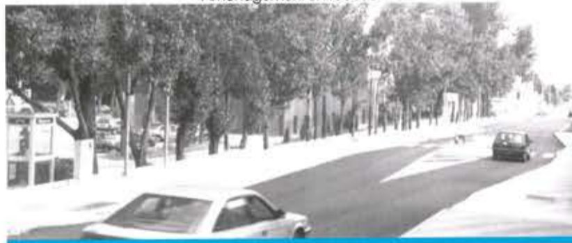
Aménagement entrée Sud
