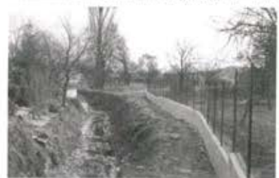
Assainissement refait dans le quartier du Valat
