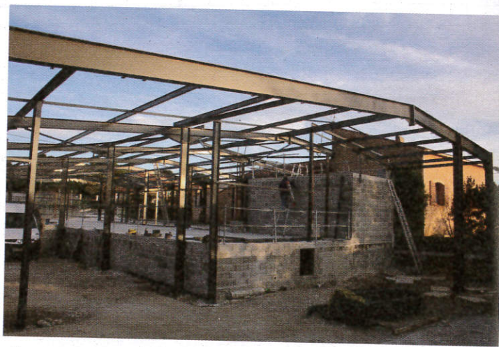
Charpente de la cuisine scolaire.
