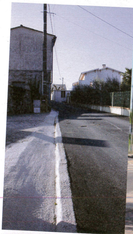
Travaux d'enrobages et évacuation des eaux pluviales
