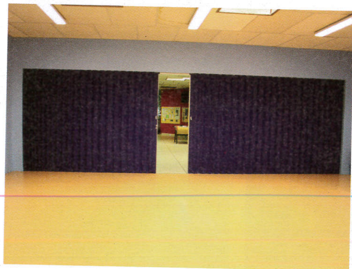
Pose d'une cloison amovible au foyer.
