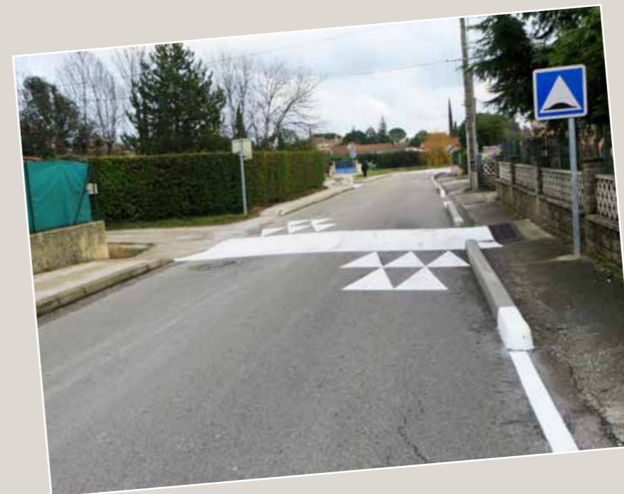
Mise en sécurité des piétons
