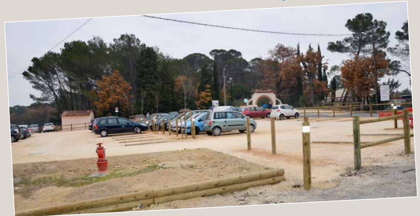
Aménagement parking du Rouret
