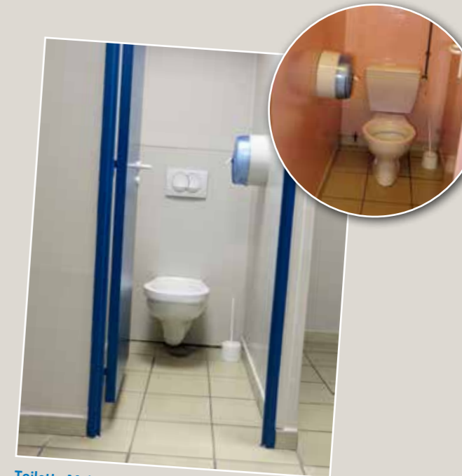
Toilette Maison pour Tous (avant - après)
