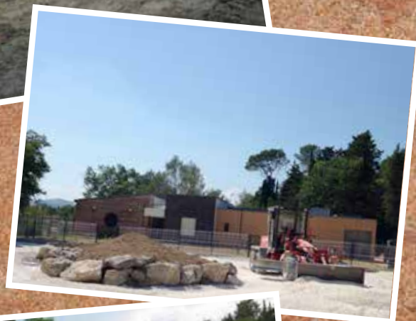
Le parking en cours de finalisation
