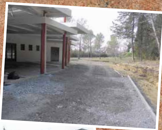
L'arrière du bâtiment en cours de terrassement
