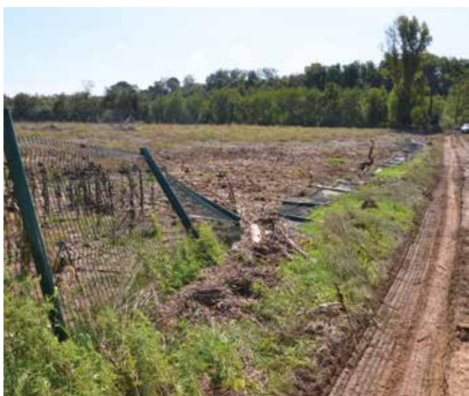
Importants dégâts en Prairie
