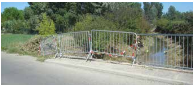
Une mise en sécurité indispensable au pont de Valès, avant la pose d'un nouveau garde-corps en commande.
